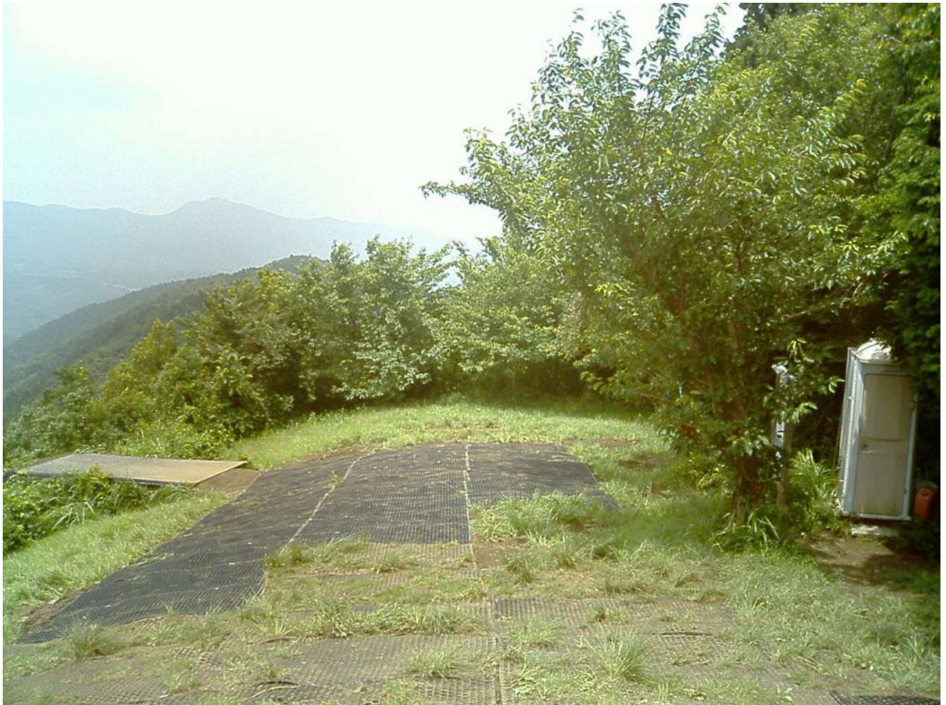
PHOTO:2004/6/27 ゴムマット敷設作業後の TO 西ランチャー台付近
